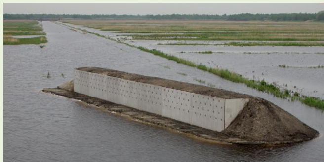
De nieuwe oeverzwaluwenwand bij de Twitterhut
