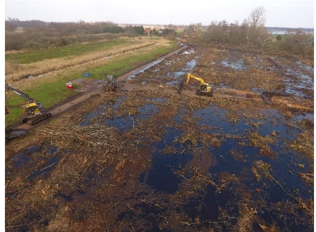
Werk in uitvoering zuidoostelijk deel deelgebied Kooi van Pen. Foto: Oosterhuis
